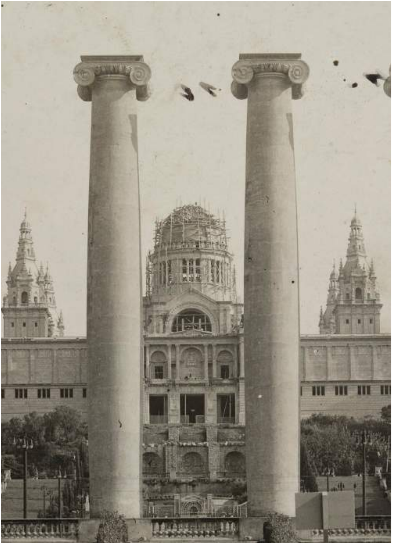
El Palau Nacional en construcció.
