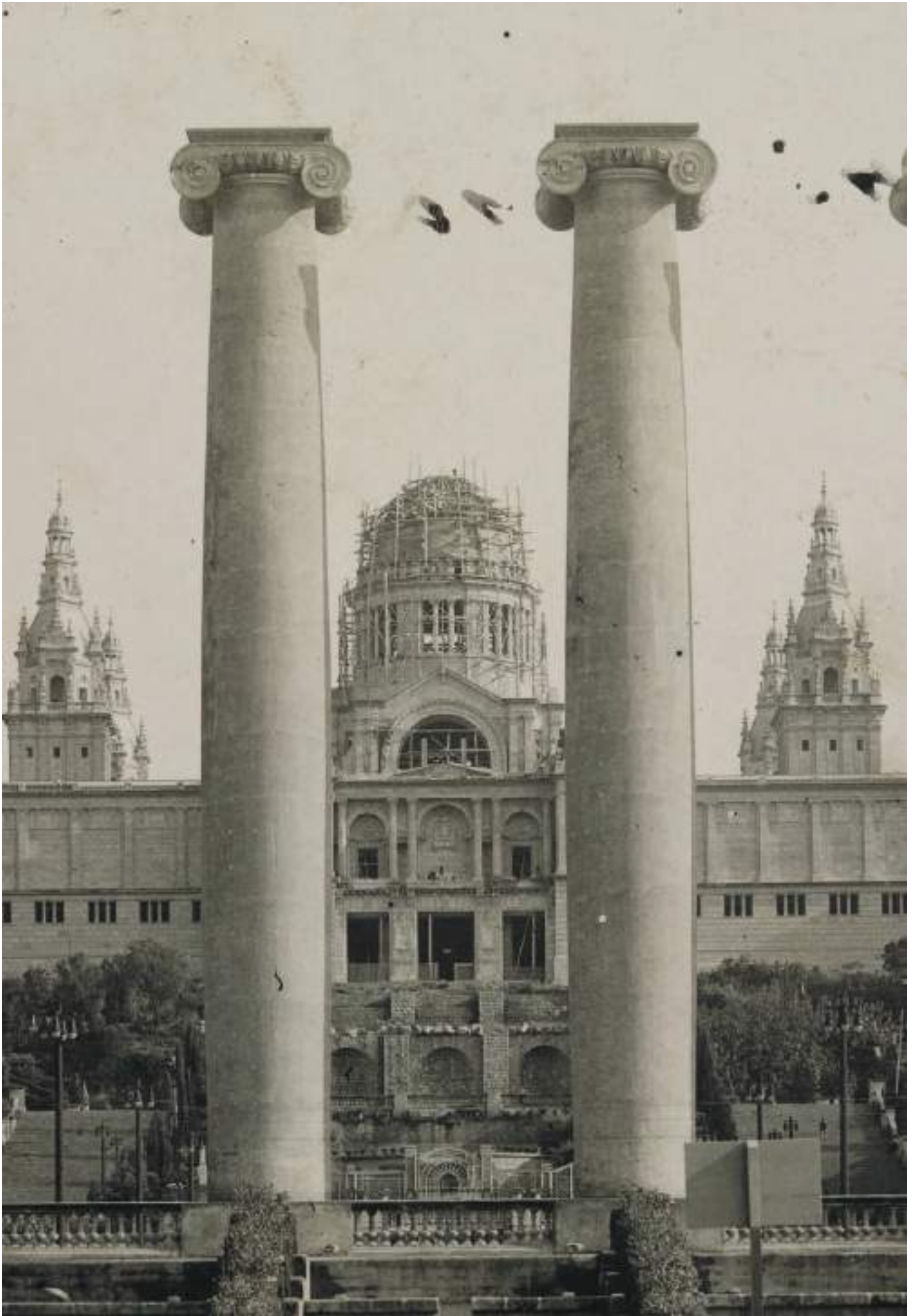
El Palau Nacional en construcci3n.
