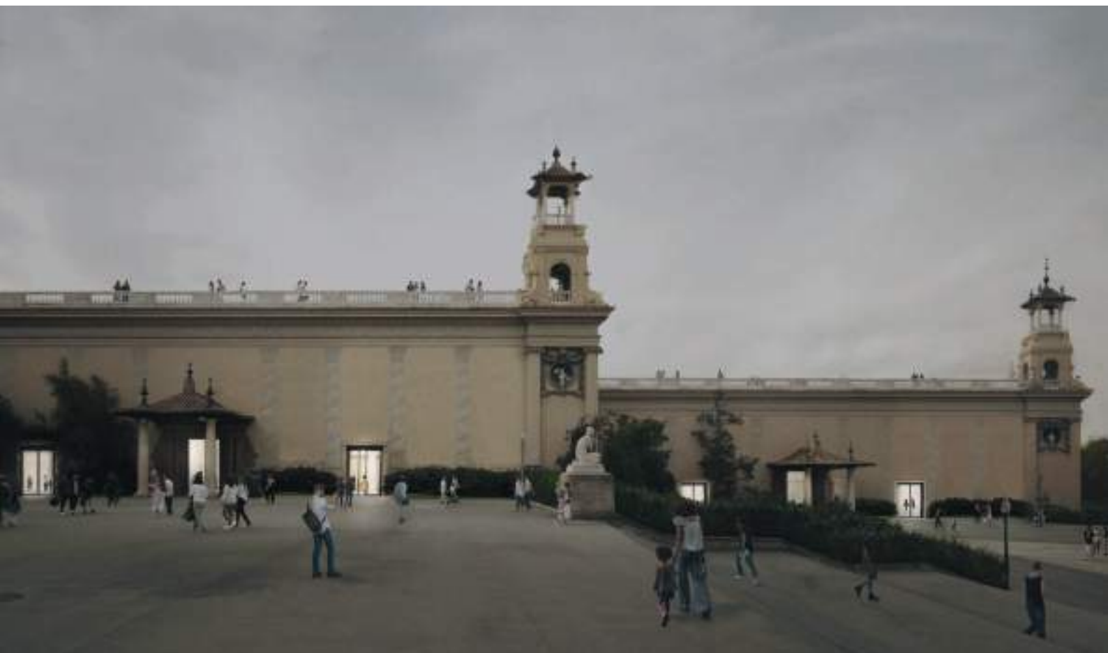
View of the Palau Victòria Eugènia lateral façade, Plaça de les Cascades.
