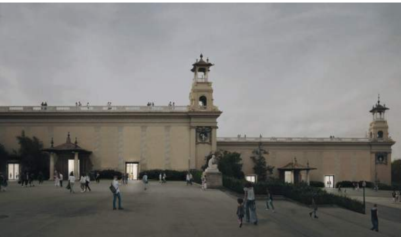
Vista de la façana lateral del Palau Victòria Eugènia, plaça de les Cascades.
