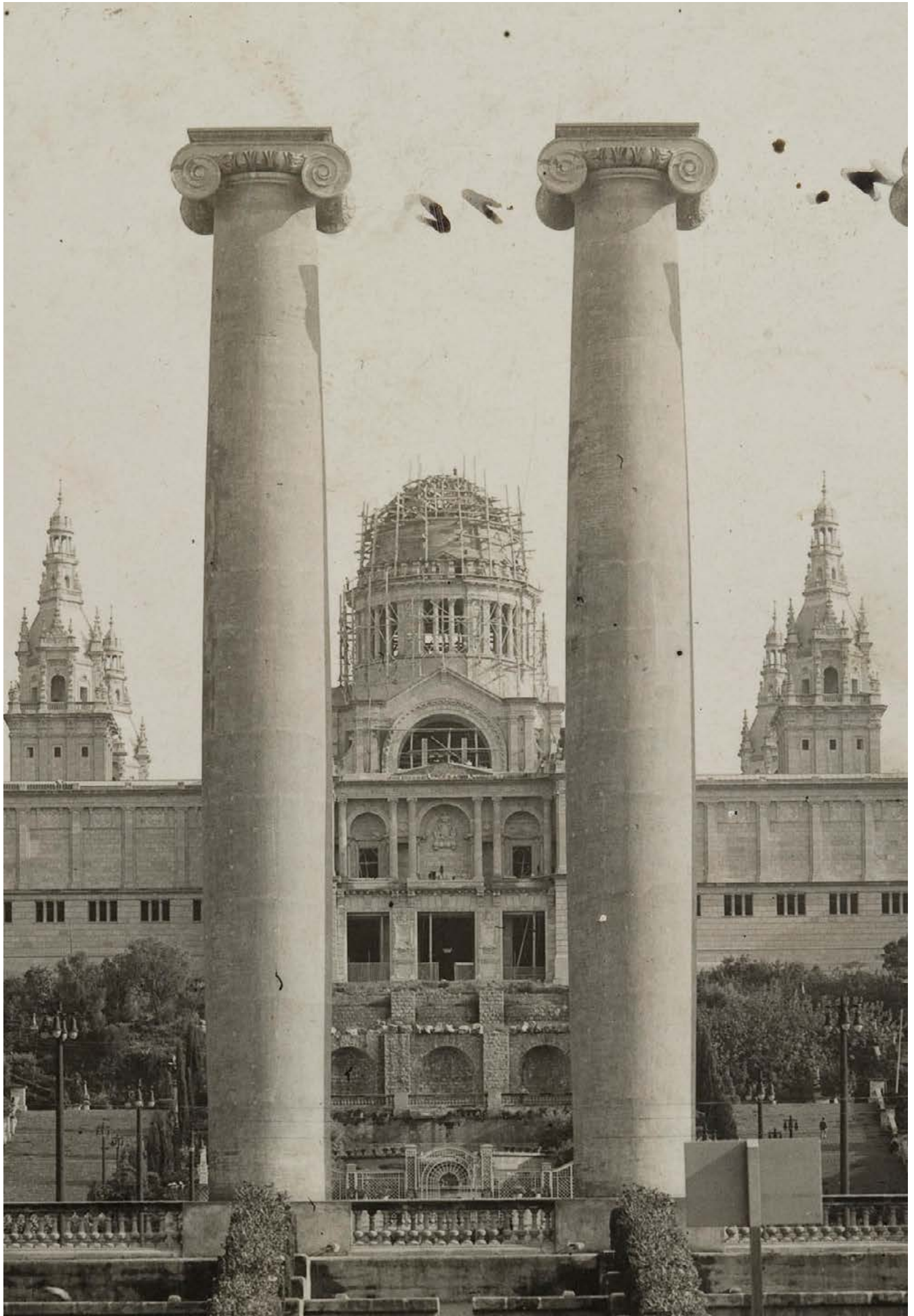
El Palacio Nacional en construcción.
