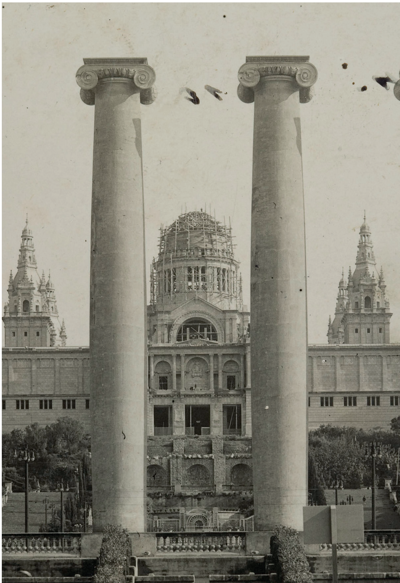
El Palau Nacional en construcció.
